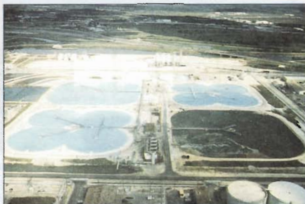
El hidróxido de magnesio se obtiene del agua de mar en los depósitos construidos por la Dow Chemical Company, en Freeport, Texas.
